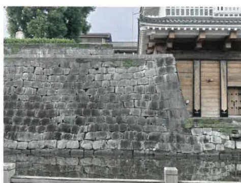
⑬H005面 御楼門南側の石垣
