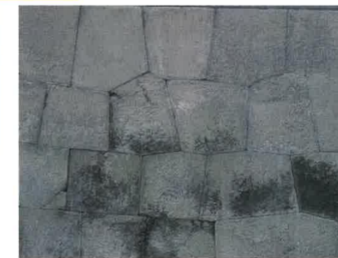
3 H011面 亀甲崩し積み
