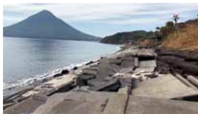
▲ 長崎鼻海岸の被災現場
