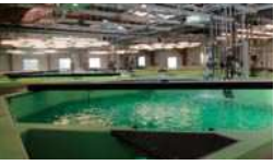
ブリ種苗生産施設
