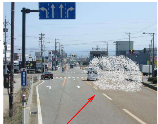
視野欠損箇所の映像(例)
