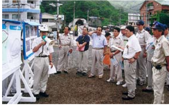
国道58号和光バイパスの工事現場(奄美市)
