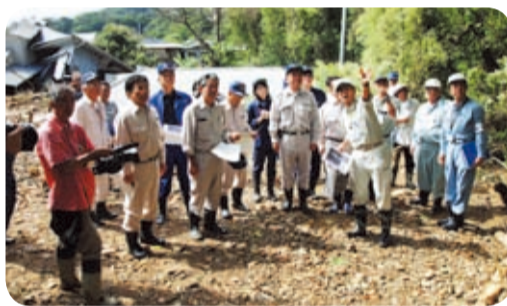
土砂流出箇所の調査(龍郷町赤尾木)
