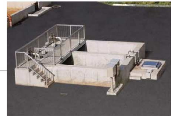
●排泥池 (管理棟から望む) 沈殿池の底に沈んだフロック(汚泥)が混ざった水が押し出されてきます。
