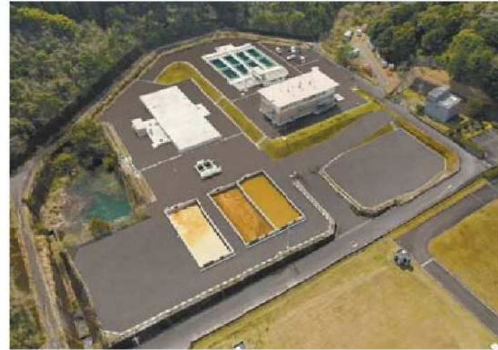
●浄水・配水施設 全景
