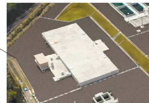
●配水池 沈殿池で水中の濁りを取り除いた水(配水)を一時的に貯えています。
