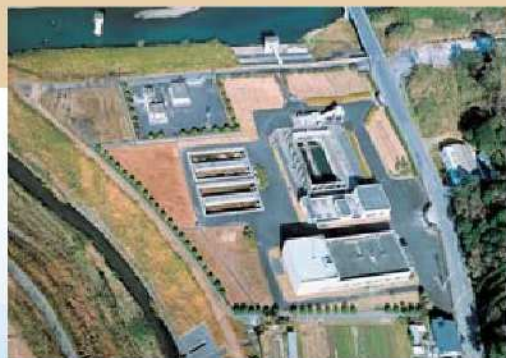
① 万之瀬取水場 万之瀬川の水を総延長20.8kmの導水路にて鹿児島市平川に送水。
