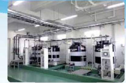
薬品注入設備 (管理棟内) 混和池で原水に凝集剤を注入して水中の濁りの粒子を凝集させ沈めます。
