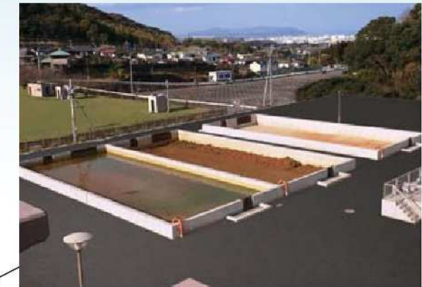
●天日乾燥床 (管理棟から望む) 排泥池から送られてきた汚泥を貯め、太陽で十分に乾燥させます。
