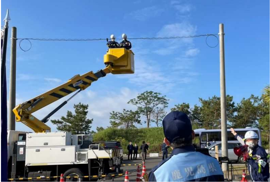
③ ライフライン復旧訓練の状況
