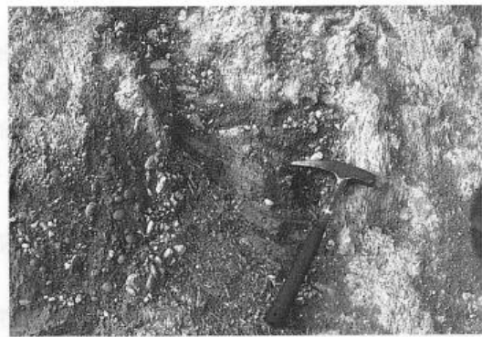
写真-13 液状化跡
