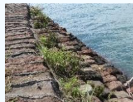
〈宮ヶ浜港防波堤〉
