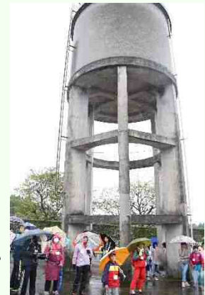
飛行場関係施設(給水塔)
