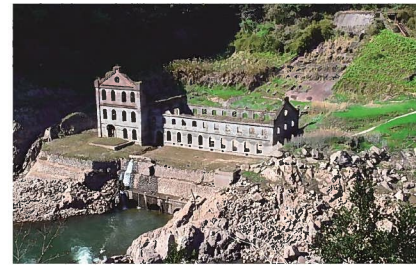
旧曾木発電所本館 (国登録有形文化財)
