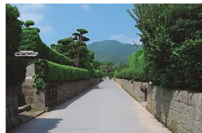
南九州市知覧伝統的建造物保存地区 (国選定)
