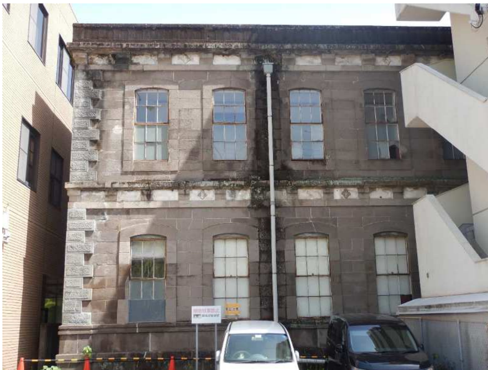
写真 1-1b 建物外観（西面）
