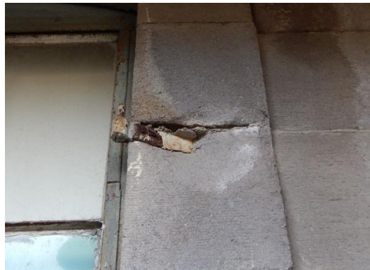
写真 1-25 膨張亀裂
