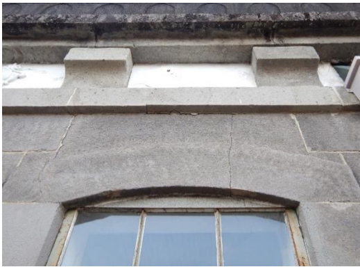
写真 1-26 曲げ亀裂
