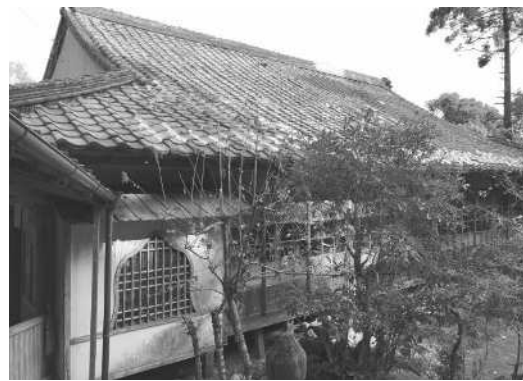
写真3 書院西側全景
