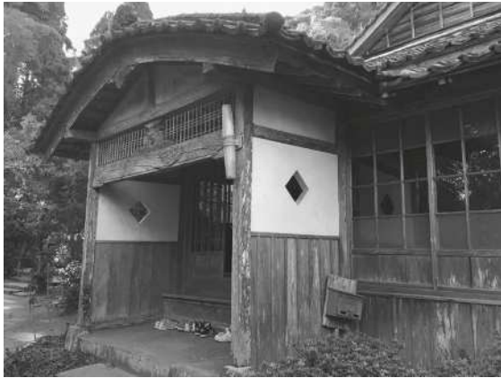
写真4 ムクリ屋根の玄関
