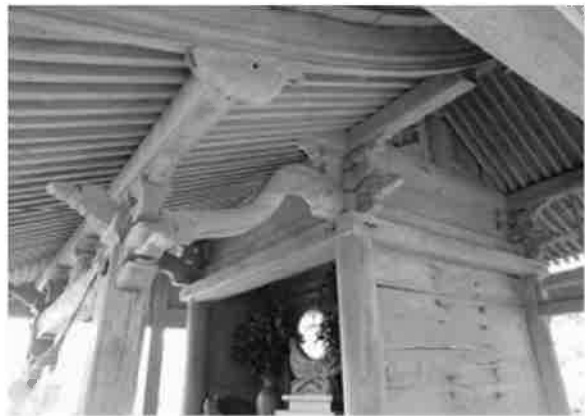
写真9 本殿右側面 向拝柱と海老虹梁
