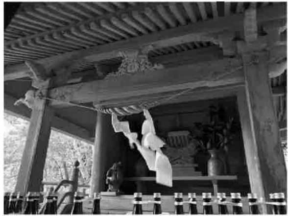
写真7 本殿正面向拝柱・水引虹梁・板墓股
