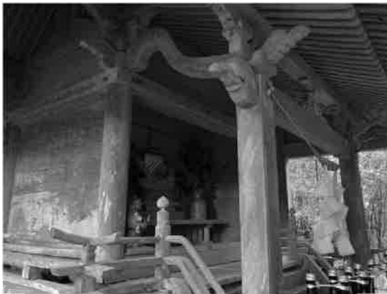
写真8 本殿左側面 向拝柱と海老虹梁
