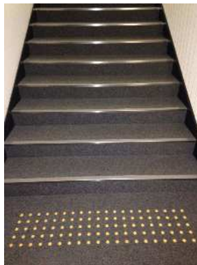
点字ブロック
