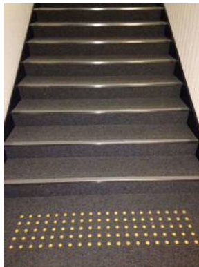
点字ブロック
