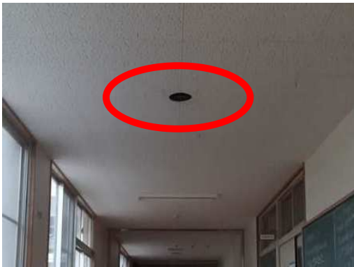
スピーカーが設置されていた天井
