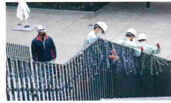
SSプラザ前 イルミネーション敷設
