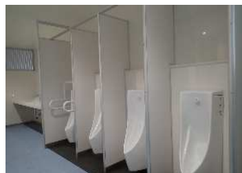
小便器の更新及び 自動水洗化
