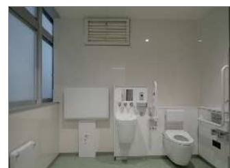
車いす対応の多機能トイレ
