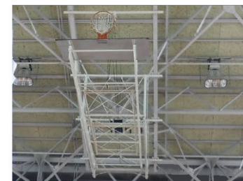
吊下式バスケットゴール 撤去前
