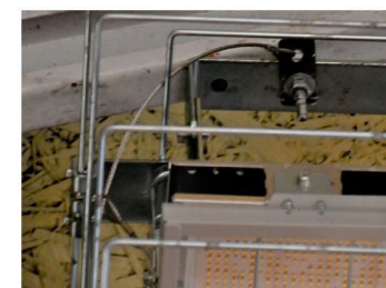
落下防止のための ワイヤー取付
