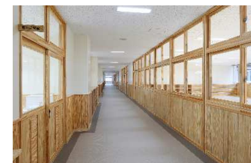
県産材を使用した腰壁と 引戸が設置された廊下
