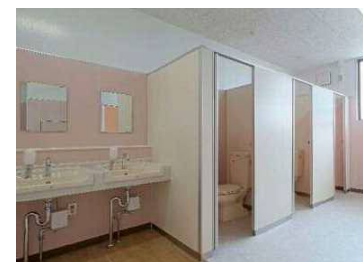
統合(改修) トイレの洋式化・乾式化
