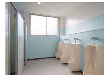
統合(改修) 採光・通風に配慮したトイレ
