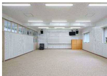
統合(改修) LED照明の設置
