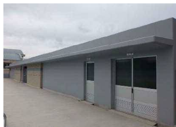
更衣室棟 RC造 (更衣室・トイレ等)
