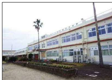
サッシと外壁の改修 外壁と屋上の防水
