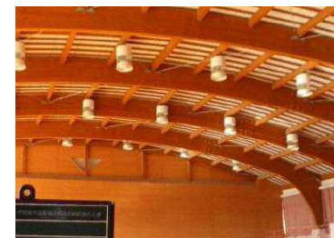
着工前写真 (玄関側の照明)
