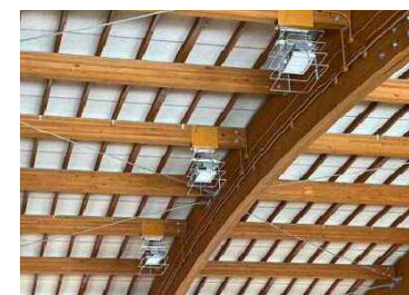
完成写真 (LED照明に改修 近景)
