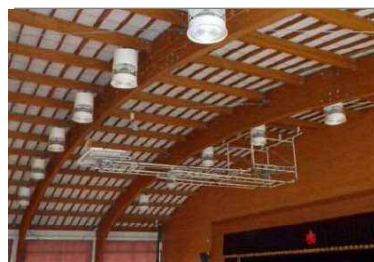
着工前写真 (吊下式バスケットゴール前)
