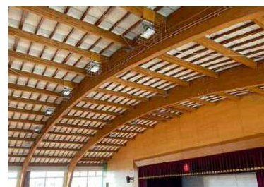
完成写真 (吊下式バスケットゴールの撤去)
