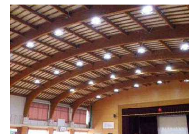
完成写真 (LED照明に改修 遠景)
