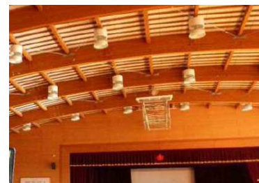
着工前写真 (ステージ側の照明)
