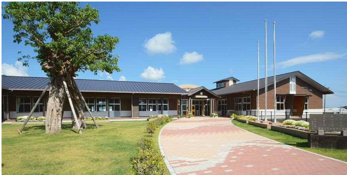
正門から昇降口アプローチ
