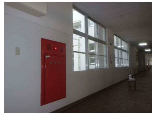
着工前 廊下の様子
