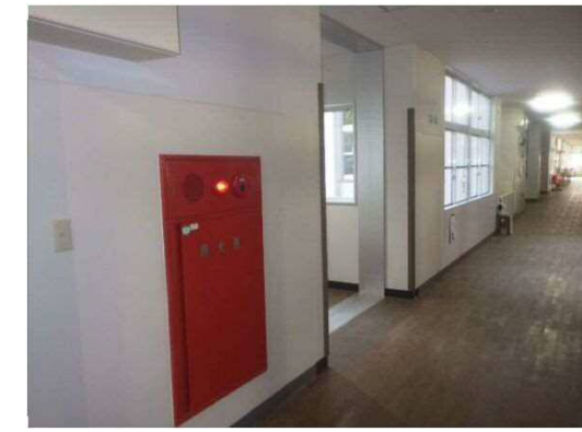
着工後 廊下の様子
