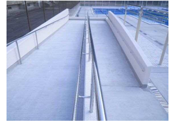
バリアフリーへの配慮 (入口スロープ)
