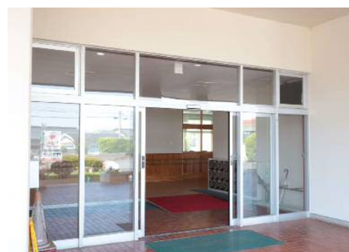
正面玄関自動ドア
