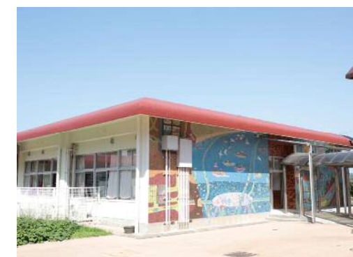
管理棟東側外観
