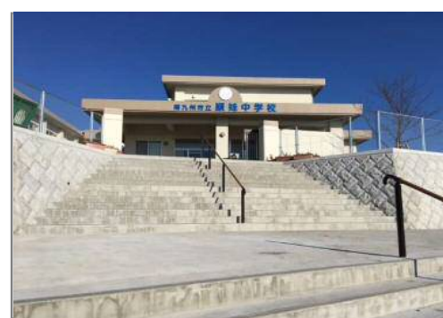
スクールバス乗降所及び 正面玄関階段を整備
