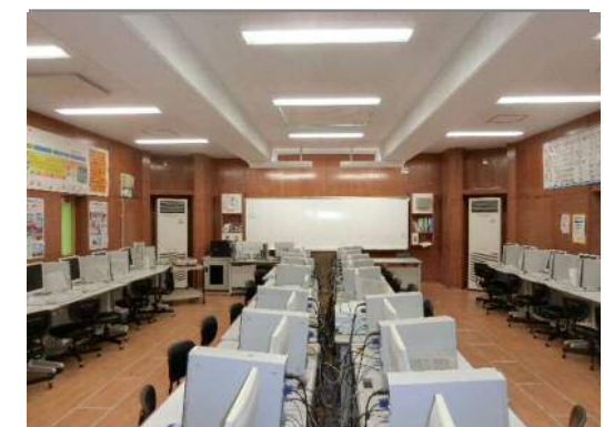
パソコン室など既設空調の更新も実施
