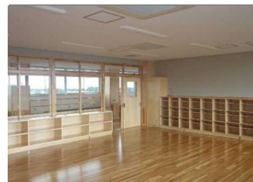
県産木材を可能な限り 使用した木質内装
