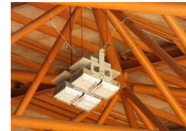
屋内運動場の天井照明を ワイヤーで補強しました
