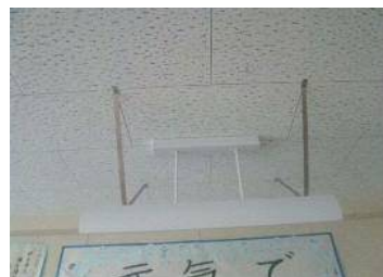
教室の吊型黒板灯に 振れ止めを設置
