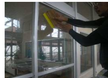
飛散防止フィルム による安全対策
