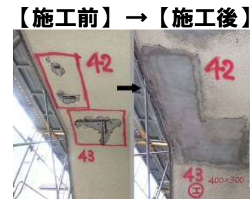
爆裂(腐食)した 外壁の改修
