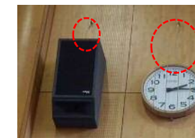
スピーカー等の落下防止 対策 (ワイヤーを設置)
