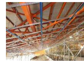
天井下地 (軽量のアルミ材)
