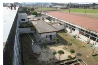
着工前（解体部分） 特別教室棟・便所棟
