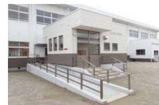
増築された玄関棟
