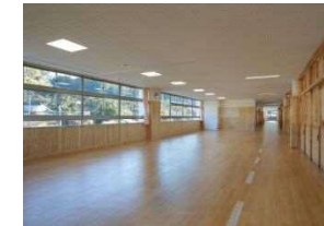
廊下と連続した多目的スペース
