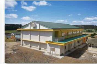
外観 北東面より望む
