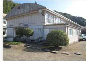
着工前の屋内運動場
