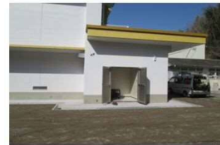
災害時に備え、非常用発電機
