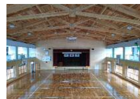
天井は木造（県産材）仕上げ
