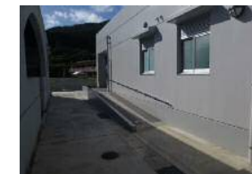
避難所に指定されているため集落側からもスロープを設置
