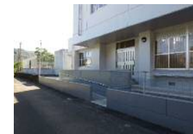
スロープを設置しバリアフリーに配慮
