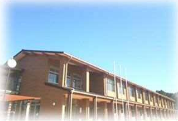
改築後校舎 木造2階建
