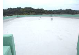
屋上は災害時の避難場所になります。
