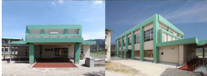
屋内運動場全景写真
