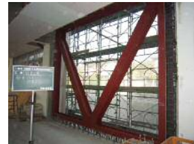
フレーム設置完了 （1F2F全22ヶ所）
