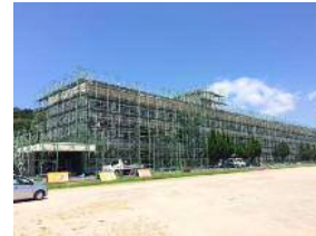
延長100m超の 外部足場、圧巻です！
