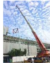
鉄骨フレーム吊り込み
