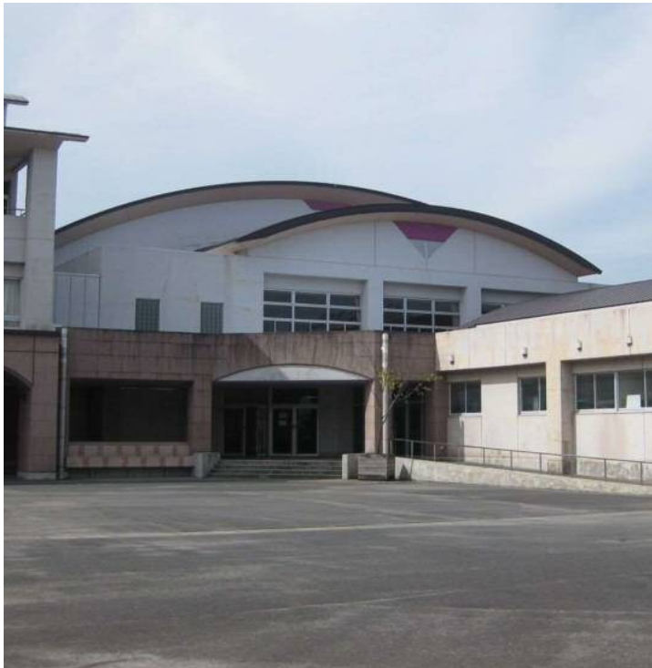
屋内運動場全景写真
