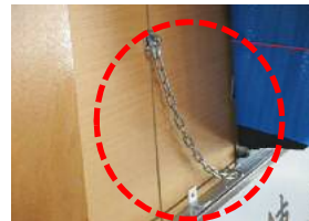
校訓の落下防止対策 (チェーンを設置)
