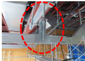
接合部の状況 (吊りボルト等)
