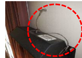
スピーカーの落下防止対策 (ワイヤーを設置)
