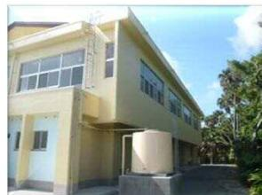
外の貯水タンク～屋上からの雨水を断水時の水まき等に使用～
