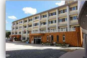
改修事業を待つ旧管理棟 （まだまだ現役です）
