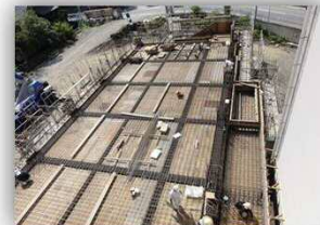
現在建築中！ （C棟これにて改築完了）
