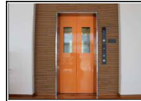
エレベータを設置 バリアフリー化を図りました
