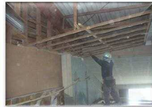
天井撤去状況
