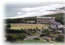
改築後の全景
