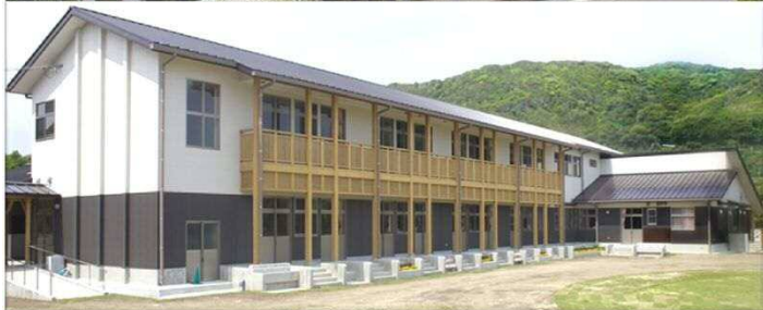
全景写真（道路側・校庭側）
