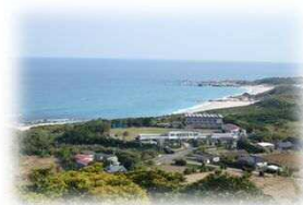
改築前の全景 昭和32年度建設の校舎（正面2階建て）
