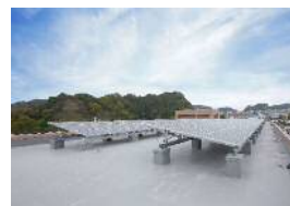
環境に配慮し太陽光パネルの設置
